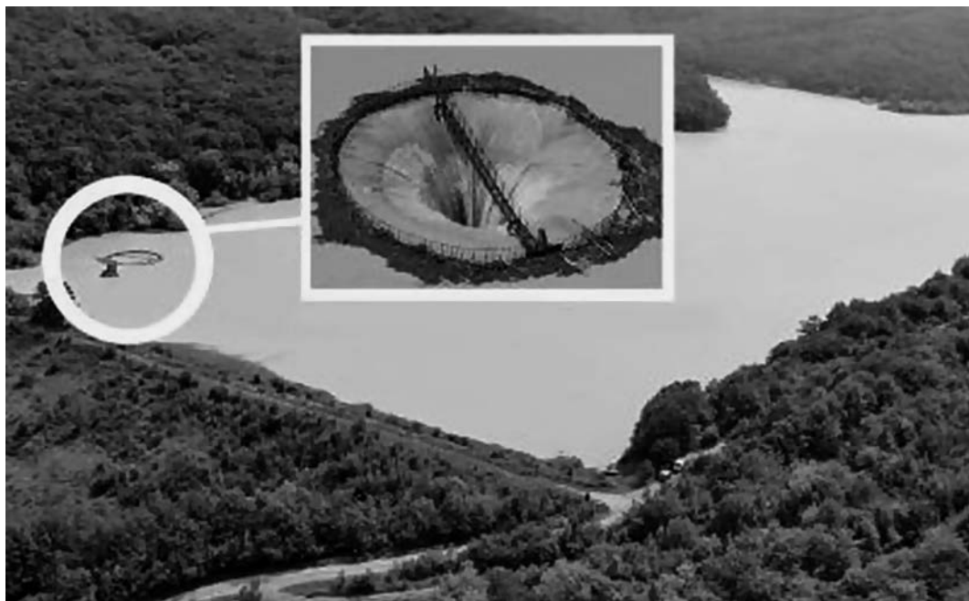
Участок Неберджаевского водохранилища с плотиной и воронкой поверхностного слива (в кружке). Воронка (во врезке) окружена металлической сеткой, защищающей железобетонный туннель от мусора.
